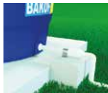
FIXAR COM abraçadeiras PARA EVITAR golpes hidráulicos. É NECESSÁRIO COLOCAR O CALÇO.
